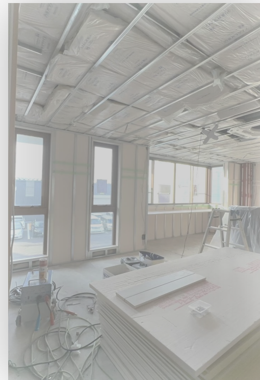
※2023年10月30日 事務所2階のリフォーム工事スタート
